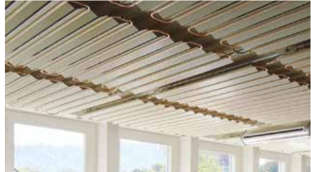
Spezial-HLM-Modul flächig angeordnet
