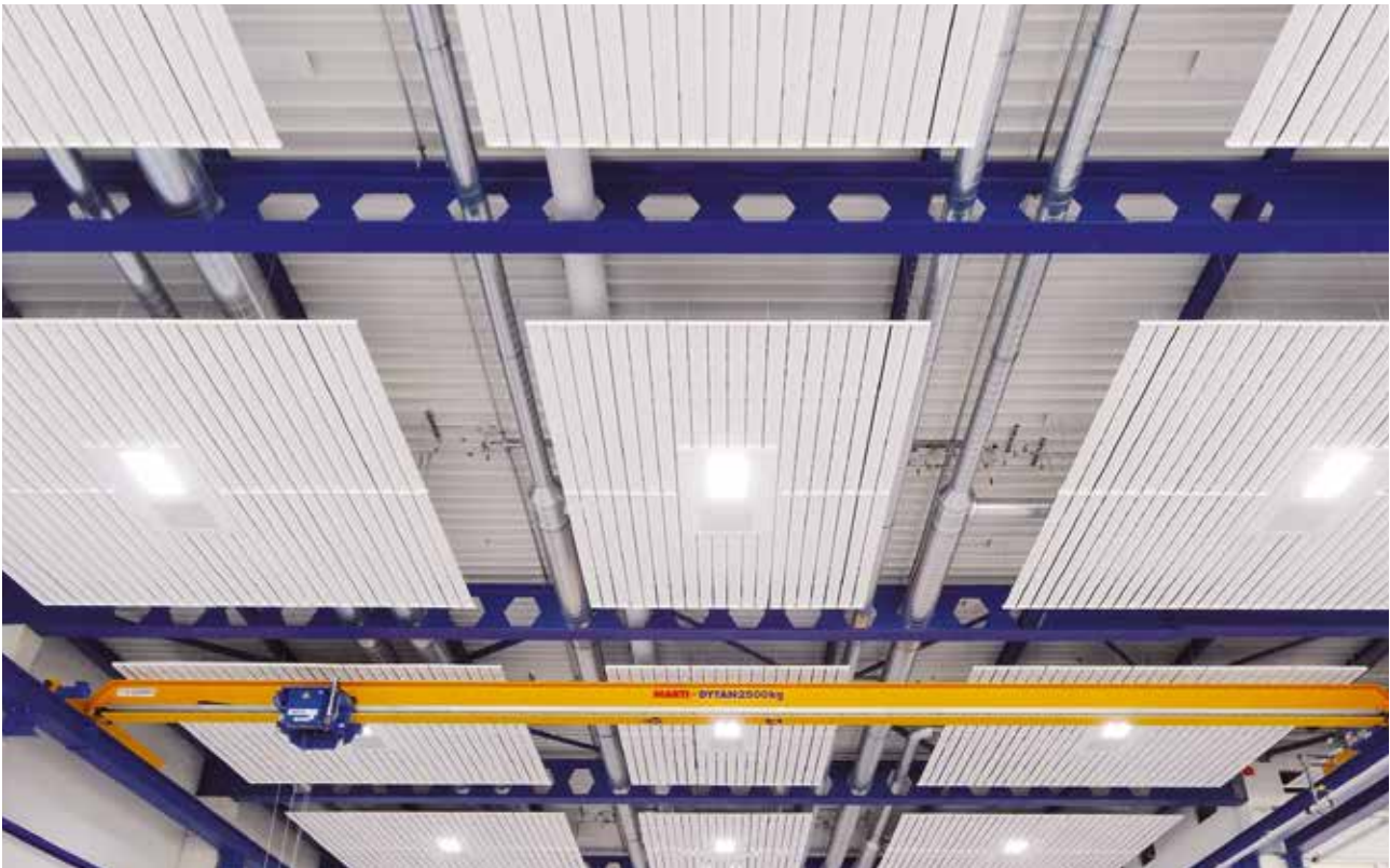
HLM-Module mit integrierter Beleuchtung und Belüftung
