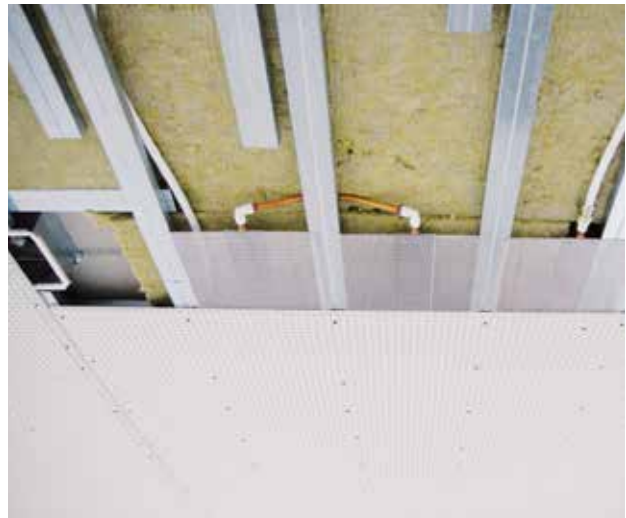
Aufbau Gipsdecke mit Kühl-/Heizregister
