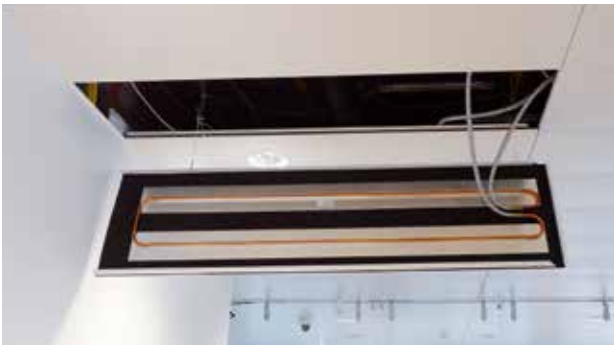
Zugänglichkeit Deckenhohlraum (seilgesicherte Kühldeckenplatte)
