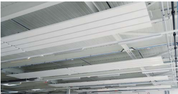
DSM-Module in Produktionshalle
